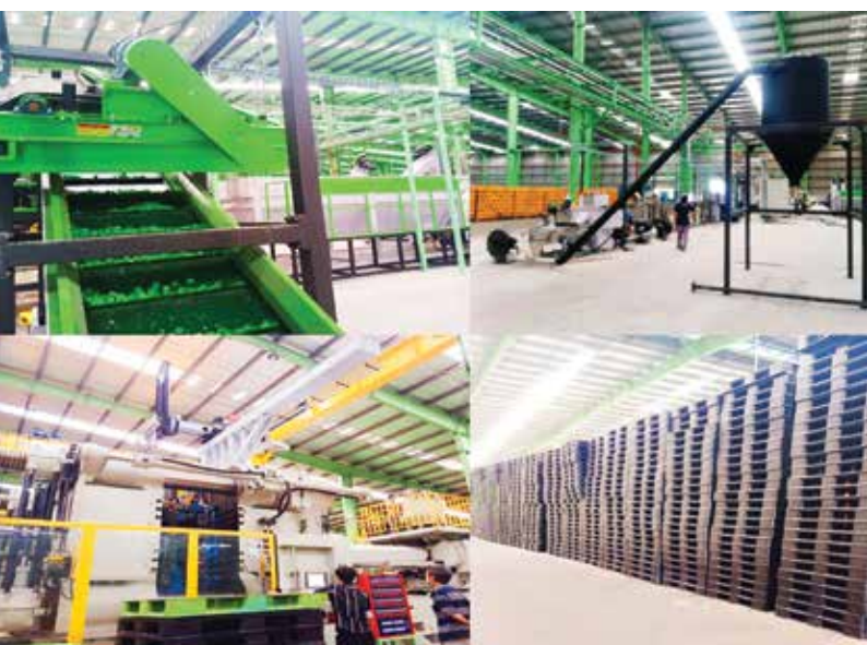
Nhà máy tái chế nhựa của Tân Hiệp Phát được đưa vào hoạt động chỉ hơn 6 tháng đầu tư, xây dựng, lắp đặt hoàn thiện.
