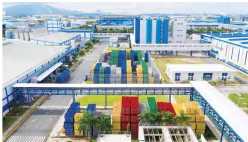
HEINEKEN Việt Nam - Vũng Tàu, nhà máy bia HEINEKEN lớn nhất khu vực Châu Á - Thái Bình Dương.
