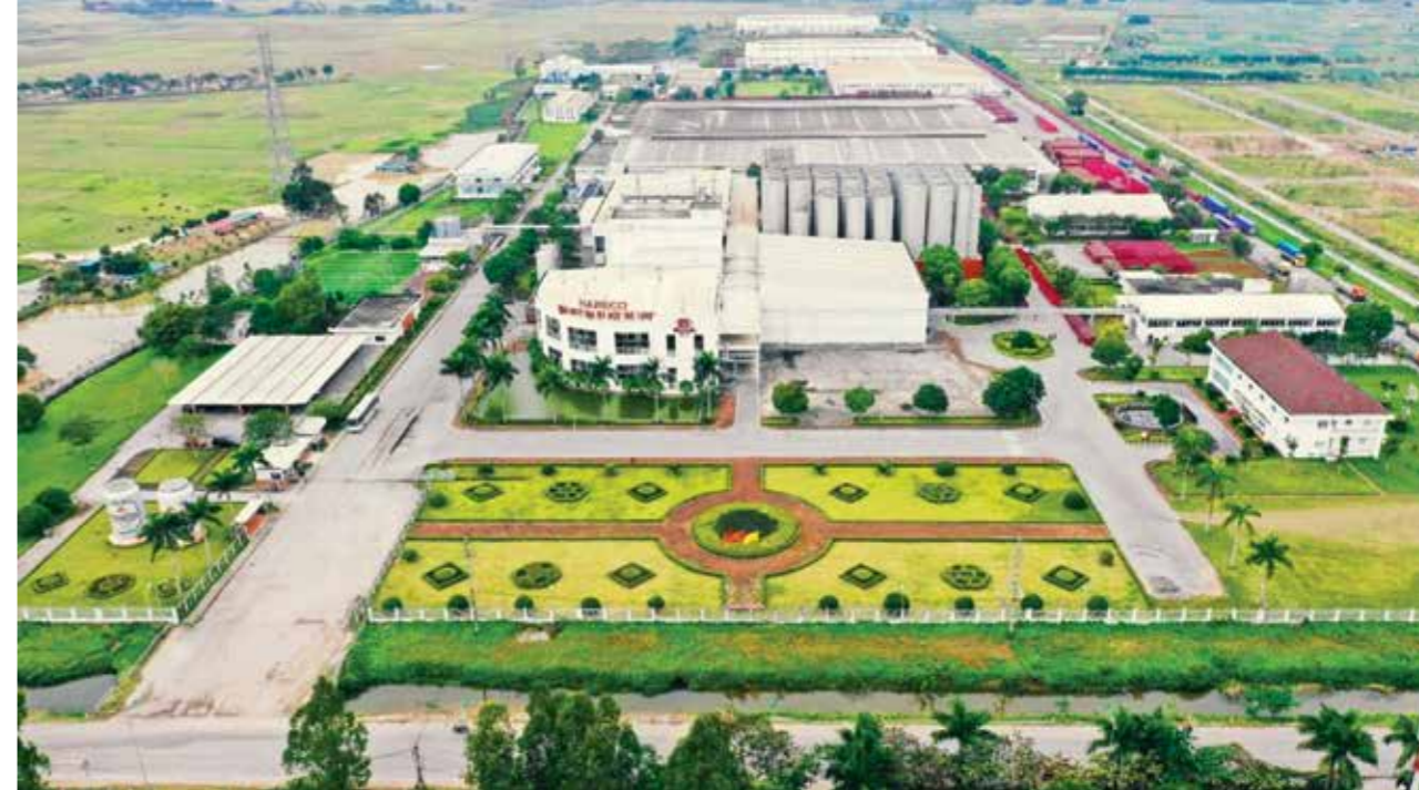
Toàn cảnh Nhà máy Bia Hà Nội - Mê Linh nhìn từ trên cao.
